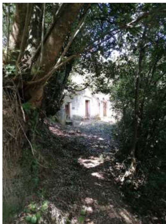
INGRESSO AL FABBRICATO
